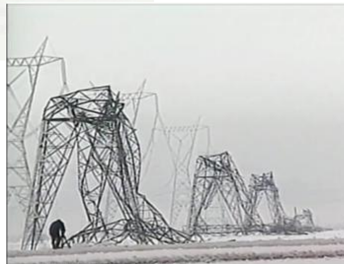
Pylônes affectés lors de la crise du verglas, en 1998 Photo: Radio-Canada
